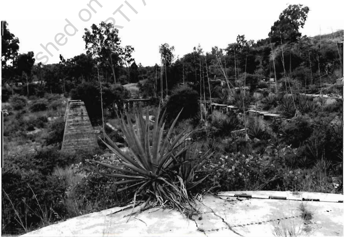
Burdekin battery looking N.
